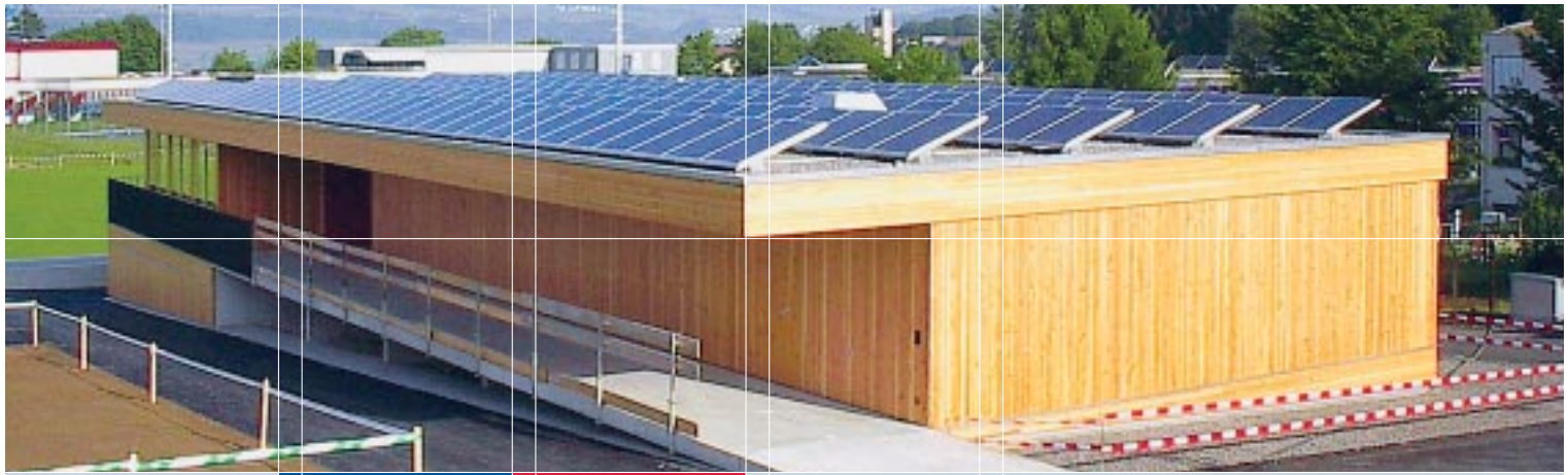
27 Kilowatt Solaranlage der EGH in Hünenberg – eine AluStand Installation
